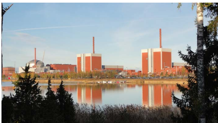
左より3号機建設中1号機・2号機
